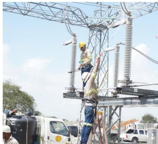
Se realizaron sustituciones en los seccionadores en los niveles de tensión de 69 y 138 kV en las subestaciones Navarrete, Km 15 de Azua, Arroyo Hondo, Palamara y PIISA. Con la instalación de estos equipos aumentó la seguridad, se redujeron los tiempos de operación y la Energía No Servida.
