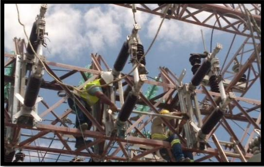
Adicionalmente, fueron ejecutados trabajos de mantenimiento predictivo y preventivo a los autotransformadores de potencia. Dichos mantenimientos consistieron básicamente en pruebas de seguimiento eléctricas y mecánicas con el objetivo de eliminar potenciales fallas y garantizar la disponibilidad de las máquinas.
