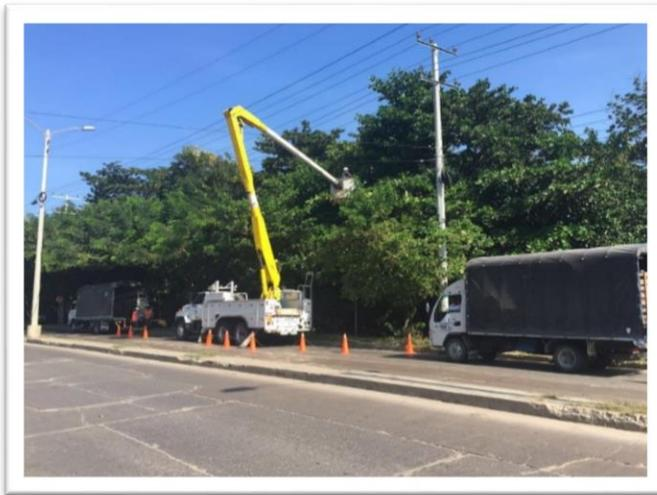
Se realizó la rehabilitación del sistema puesta a tierra en líneas de transmisión de 69, 138 y 345 kV con el objetivo de reducir las fallas por descargas atmosféricas y sobretensiones del sistema.
