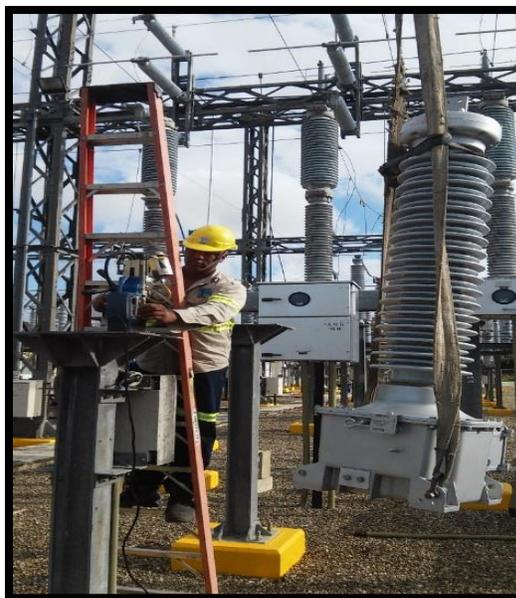
Los cambios de transformadores de tensión en las subestaciones Palamara, Haina, Valdesia, Los Mina, km 15 de Azua, San Francisco y Dajabón. Con estos trabajos se logró mejorar la continuidad del servicio y la seguridad de las instalaciones evitando potenciales fallas de los equipos.
