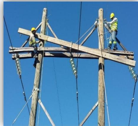
Se realizó la sustitución de aisladores por agotamiento de las líneas de transmisión de 69 y 138 kV con la finalidad de reducir las fallas en la red de transmisión y de esa forma dar un mejor servicio a nuestros clientes.
